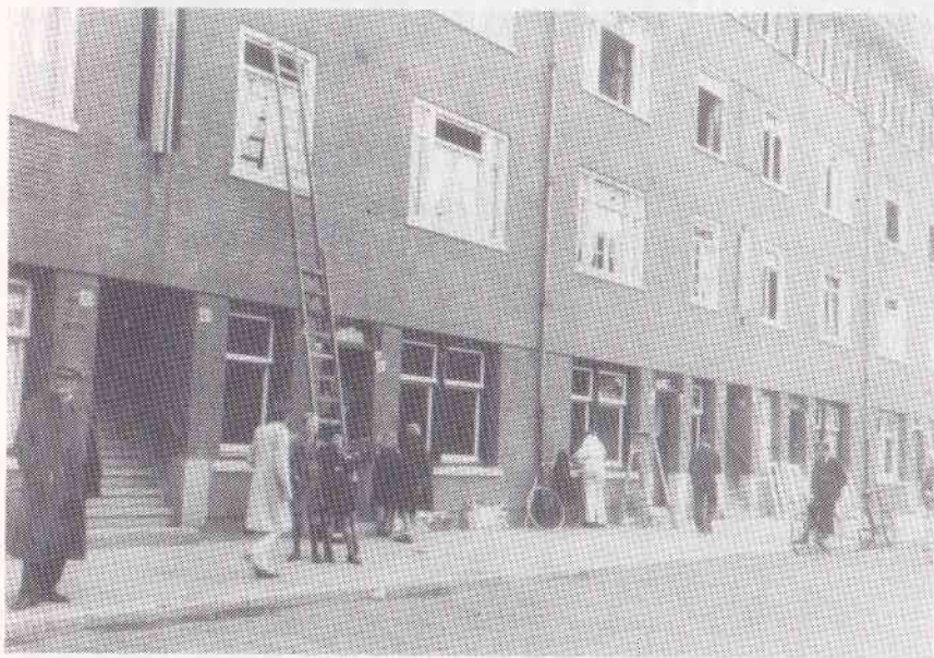
De schade wordt hersteld.
